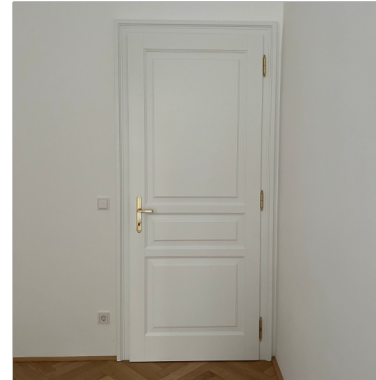
Innentüren Firma Nibla Fräsung Alt Wien Standart Türscharniere: Simonswerk V7939/120 Oberfläche: RAL 9016
