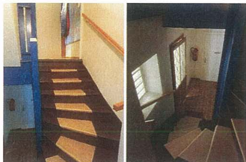
Stiegenhaus Wohnhaus Altbestand Abgang OG - EG
