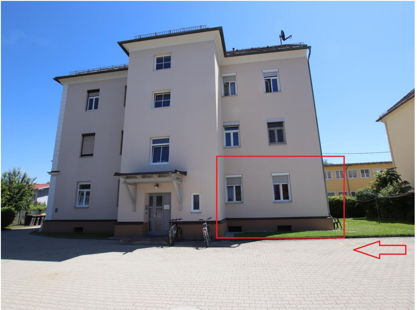
Schöne sanierte Garconniere in Klagenfurt
